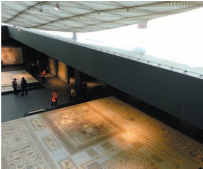
伊斯蘭藝術展館的展區罩頂狀如阿拉伯飛毯，由八千枝空心管支撐兩千多片三角型鋼鐵框架與鋼絲網片，地下展示透明和不透明的三角形玻璃平面鑲嵌畫。
