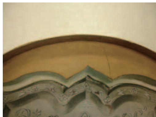
圖四 錦托洞與木托洞上方有傷裂紋
