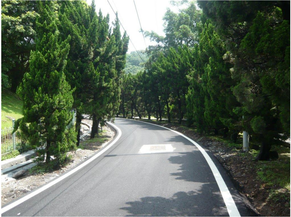
本院道路工程東側完工部分現場情景 D (1)
