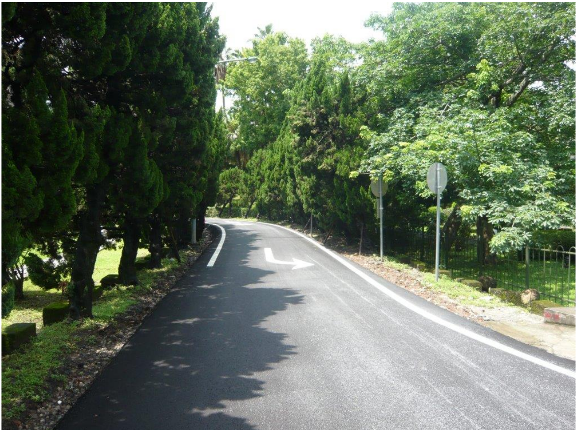
本院道路工程東側完工部分現場情景 B (2)
