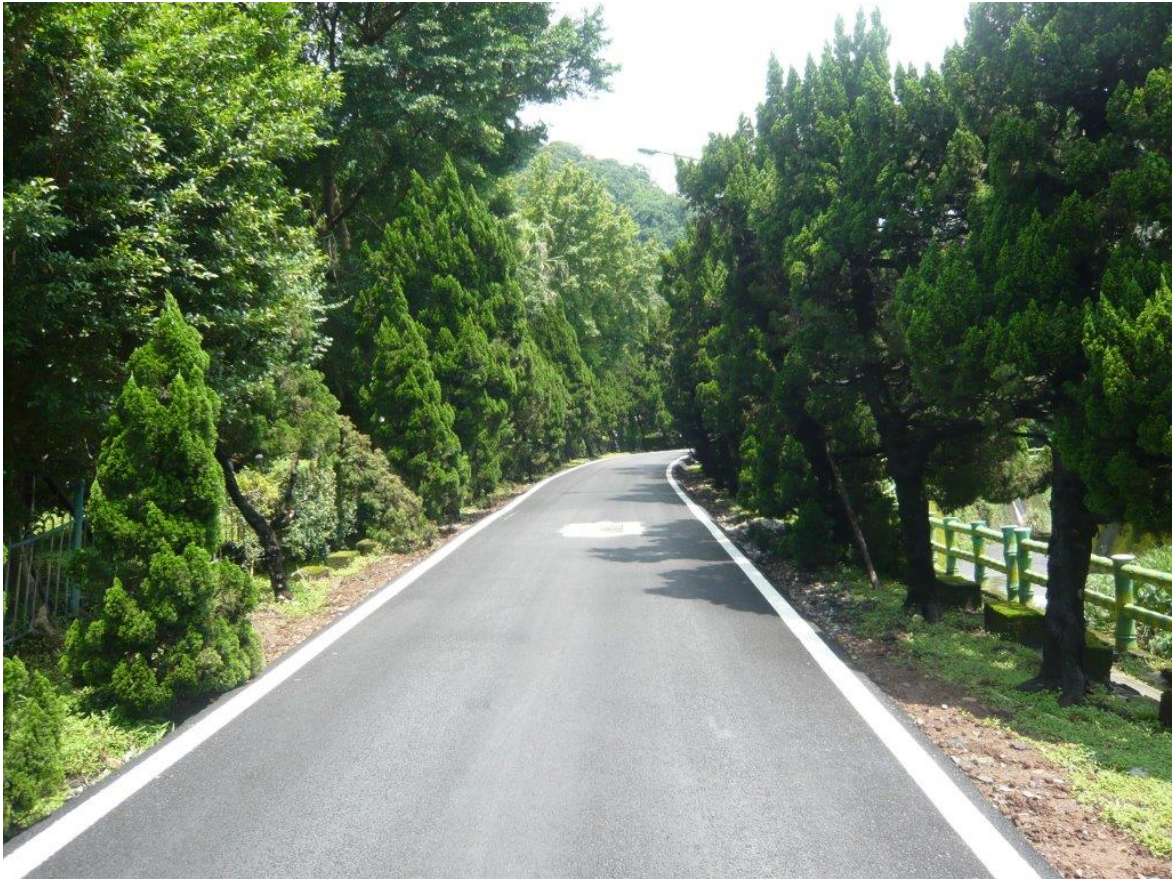
本院道路工程東側完工部分現場情景 B (1)
