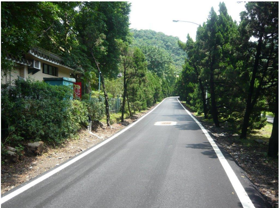
本院道路工程東側完工部分現場情景 D (2)
