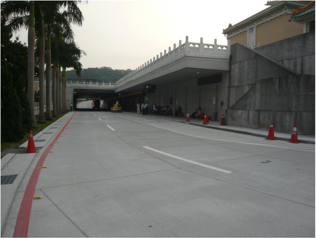
本院道路工程竣工情景 (5)
