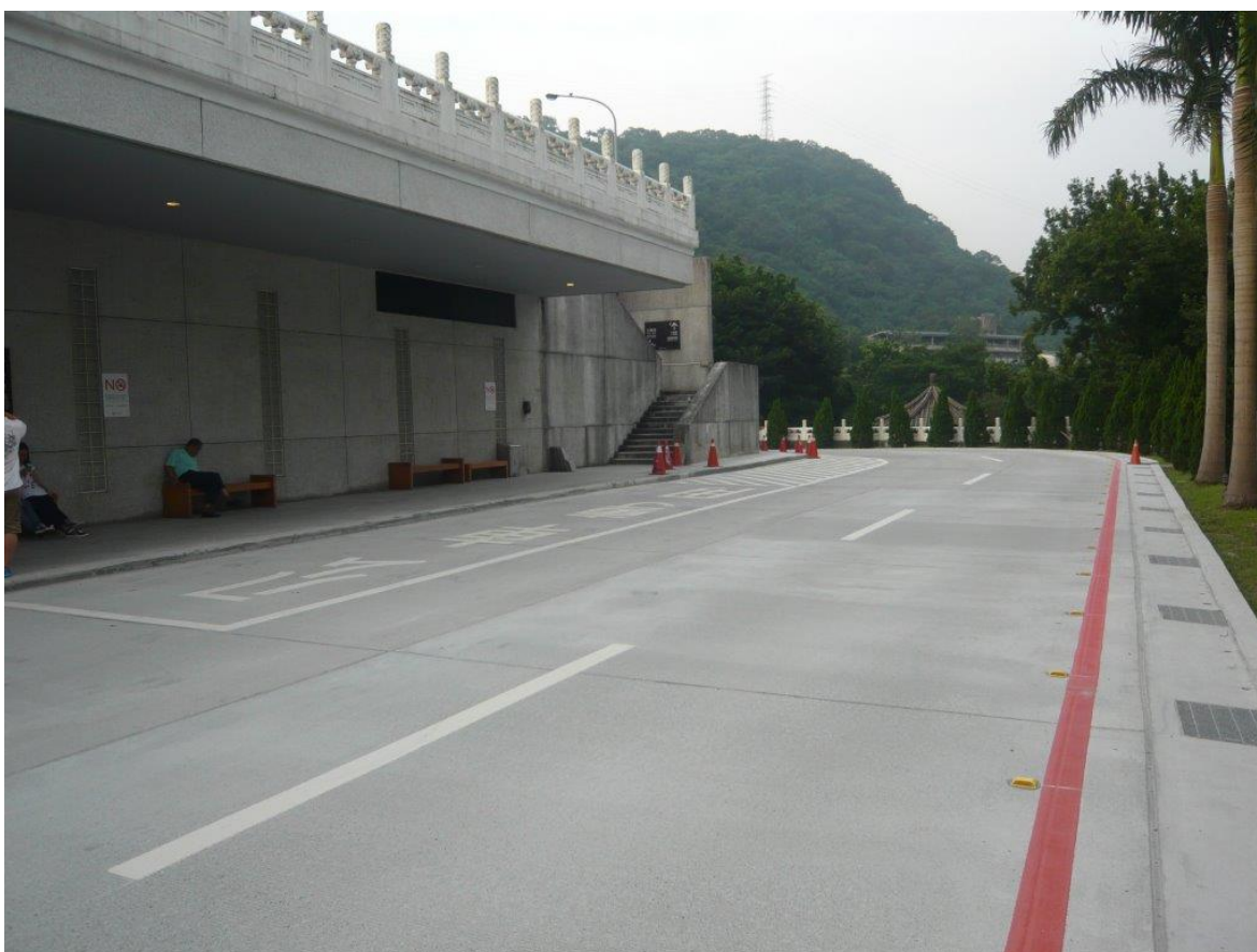
本院道路工程竣工情景 (4)
