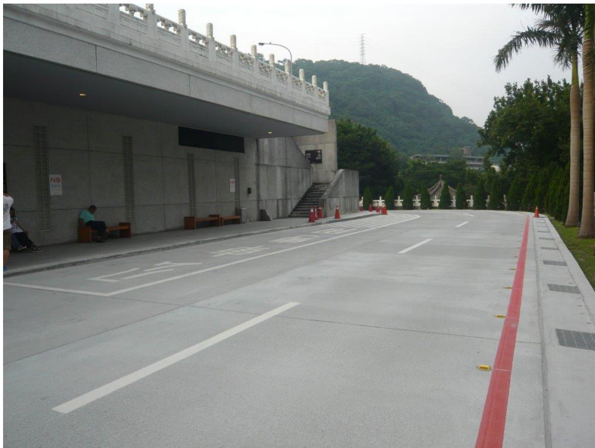
本院道路工程竣工情景 (3)
