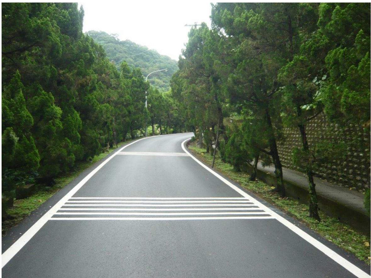
本院道路工程竣工情景 (2)
