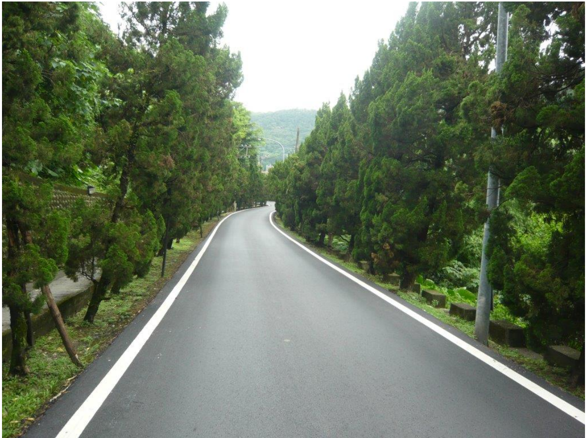
本院道路工程竣工情景 (1)
