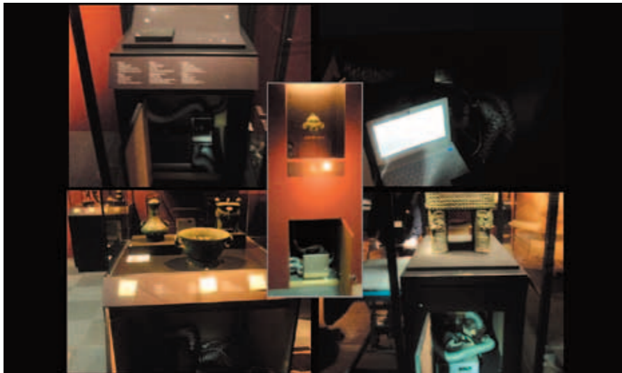
圖四 「武丁與婦好特展」新製木櫃及原有鐵框玻璃櫃下均裝置控濕機組。 作者提供
